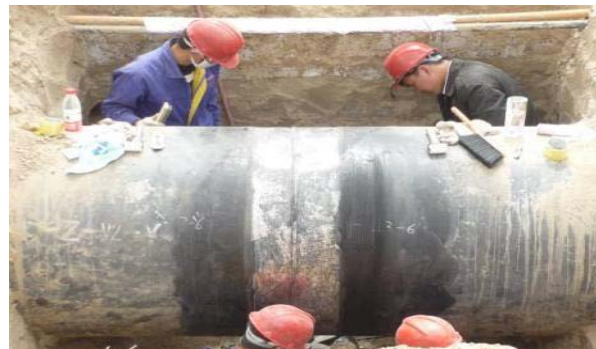
电动工具除锈、手工除尘
