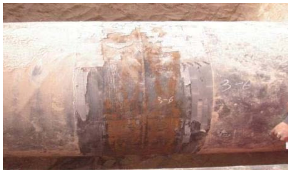
热收缩带整体剥除
